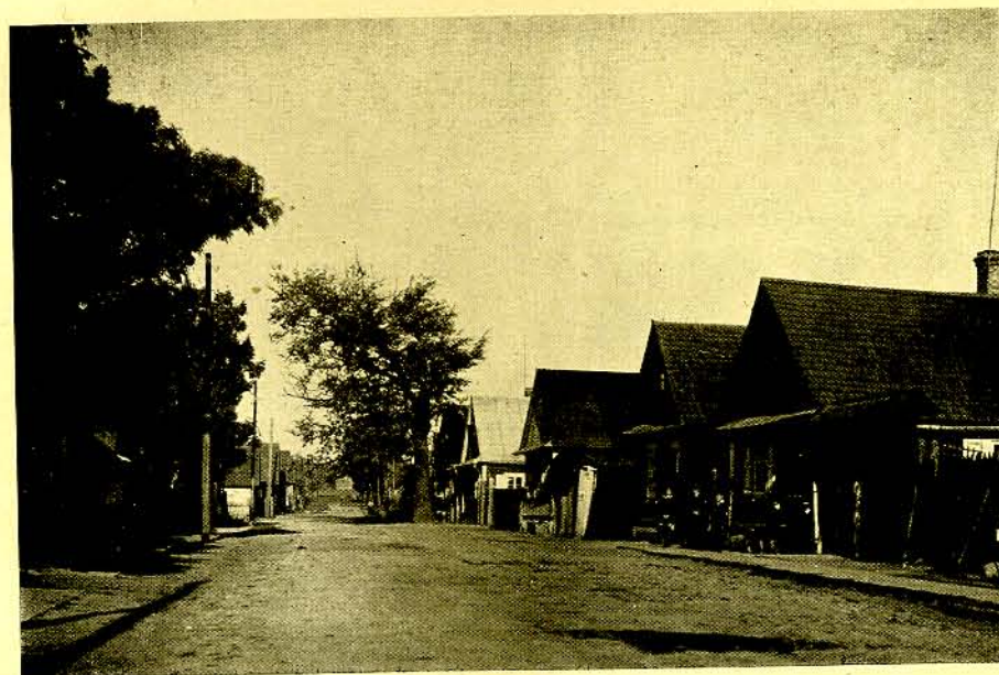
Ulica Tatarska w Słonimie. Rue des Tatares à Słonim.
